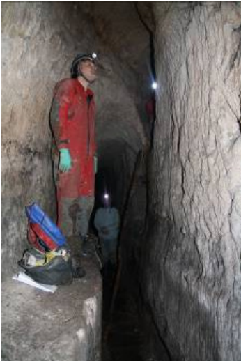
Abb. 2: Mehrere Prospektions- und Wasserseigenstollen führen auf unterschiedlichen Ebenen zusammen, markiert durch die drei Personen mit Lampen. (Foto: Bernhard Häck, BLFD)
